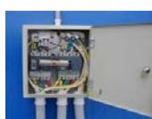
**8) Вводно-распределительное устройство** предназначено для коммутации внешней нагрузки с фидером внешней сети или с ДГУ в блок-контейнере через автоматические выключатели.
