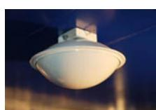
**10) Система автоматического пожаротушения** предназначена для локализации и тушения горючих жидкостей и электрооборудования, находящегося под напряжением. Срабатывает самостоятельно, при достижении температуры 85°C.
